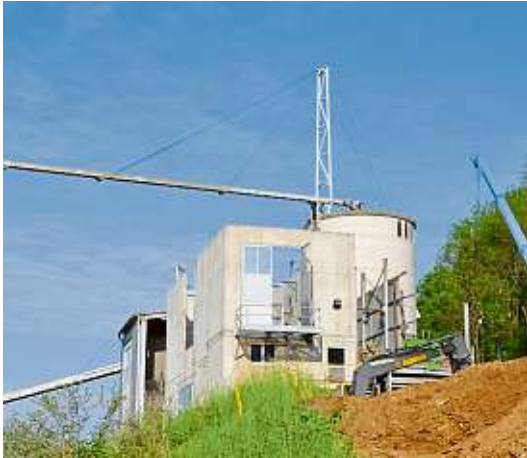
Bauarbeiten beim Heiz- werk in Lie- benfels HOLZFEIND
